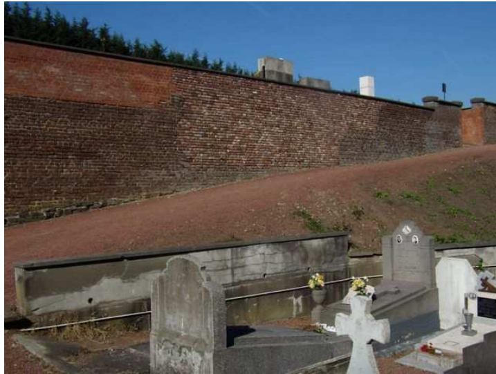
Mur intérieur rehaussé et restauré, suite à la construction de la dernière extension du cimetière
