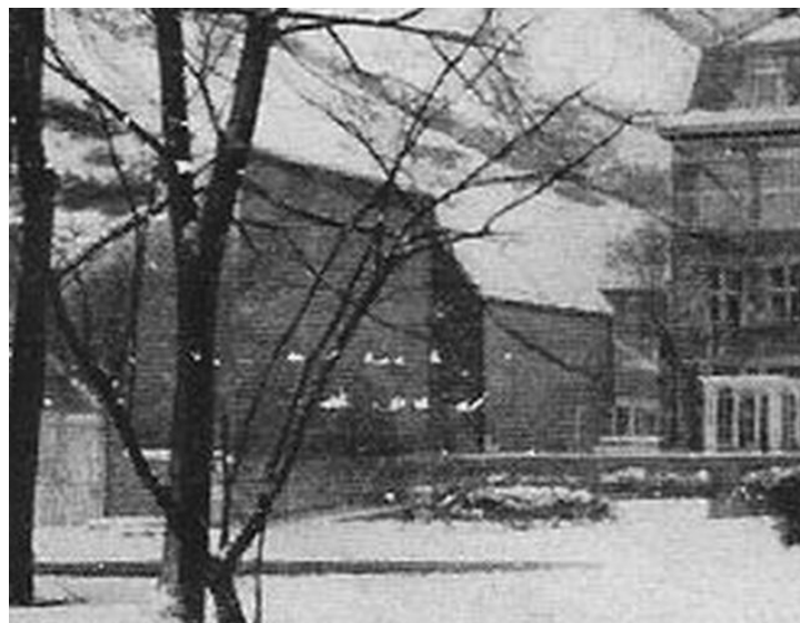
Vue arrière de la maison Asnong depuis le parc du château
