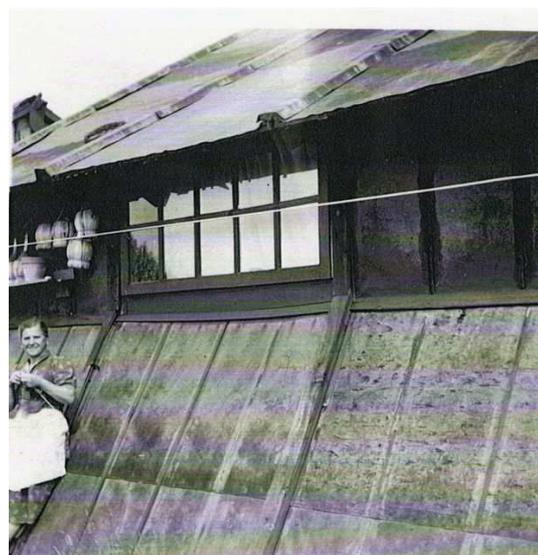
L'arrière des logements était aussi doté des même fenêtres à ouvrant à bascule et des mêmes panneaux de bois obliques . Entre les espaces réservés aux fenêtres , s'élevaient des panneaux
