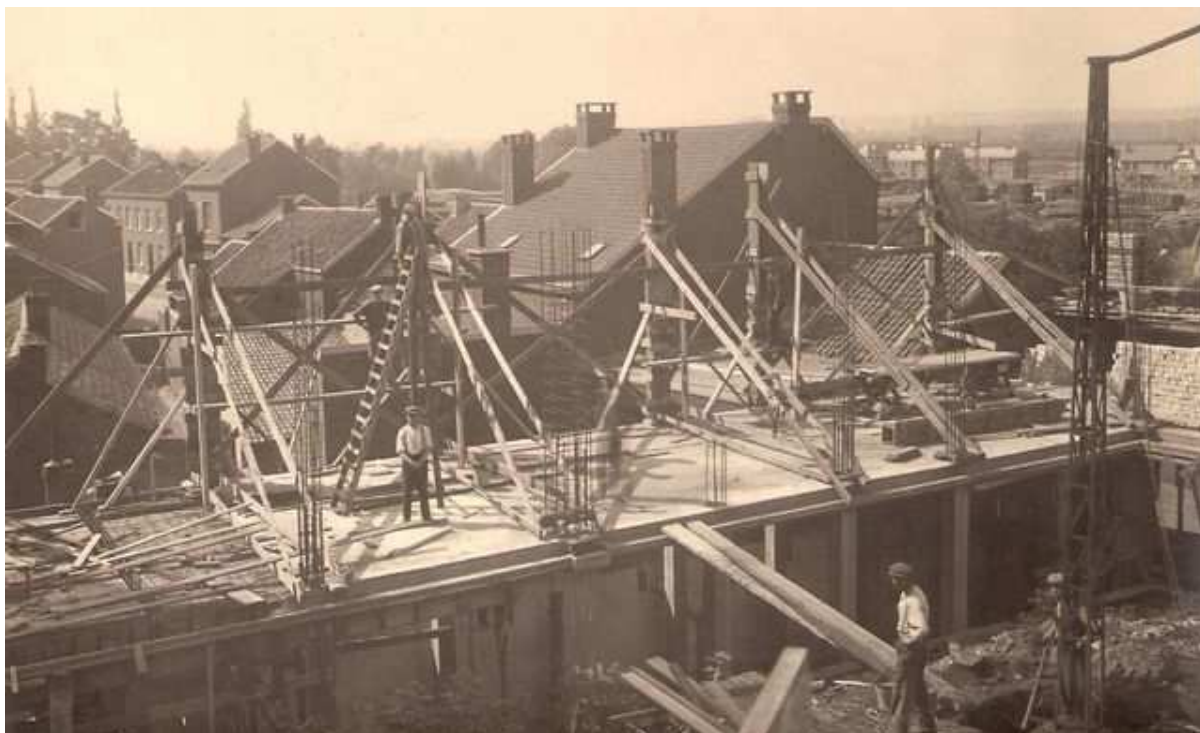
Sur la photo de la construction de la passerelle du charbonnage , on peut voir l'arrière de la toiture de cette maison vers 1923 , ainsi que les toitures des maisons annexes .
